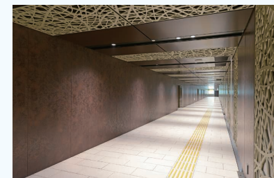
セラール セレント 施工事例
