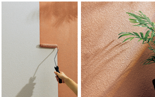
〔ローラーで施工〕
