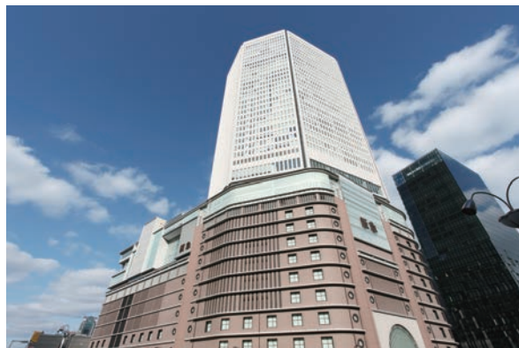
アイカテック建材株式会社 押出成形セメント板「メース」採用物件 <梅田阪急ビル(大阪府)> 設計：株式会社日建設計 施工：株式会社大林組
