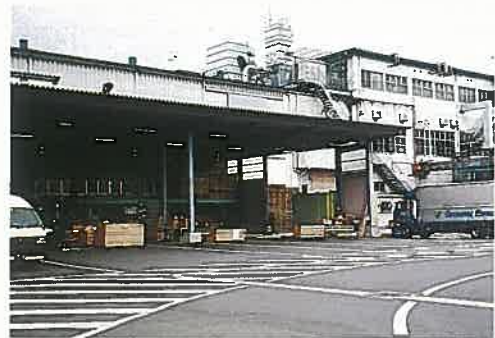
積み込みヤード
