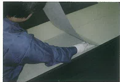
剥離可能化粧板（剥離作業）
