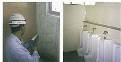
セラールonタイル施工作業 セラールonタイル施工例
