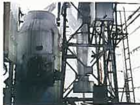
休止した新川工場の廃プラスチック焼却炉
