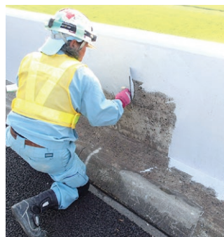
不陸調整作業
