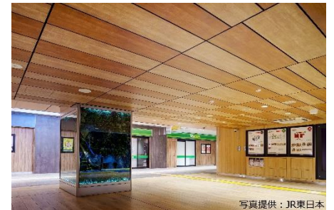
▲新工法で施工されたセラール
