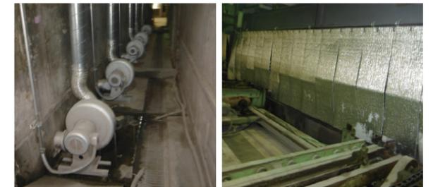
養生庫内温度安定化のために新規設置した送風ファン(左)、保温カーテン(右)
