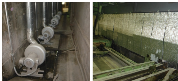
为了稳定养护仓内部温度而新设置的通风扇 (左) 与保温帘 (右)
