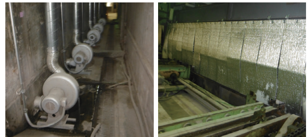
養生庫内温度安定化のために新規設置した送風ファン(左)、保温カーテン(右)
