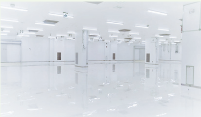
在大型半导体工厂等应用范围不断扩大的地板漆“Fabbrica”的施工情形
