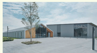
「パッシブウォール」施工例
