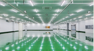
“Fabbrica 流延 SCR 施工法”施工场景
