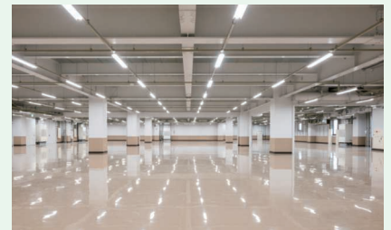
塗り床材「ジョリエース」施工例
