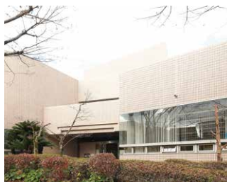
タイル補修工法施工事例 (富士宮市立図書館)
