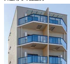
「ジョリパット」のマンション 外壁用での施工例
