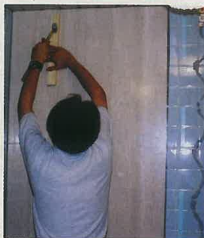
●セラールonタイル施工風景
