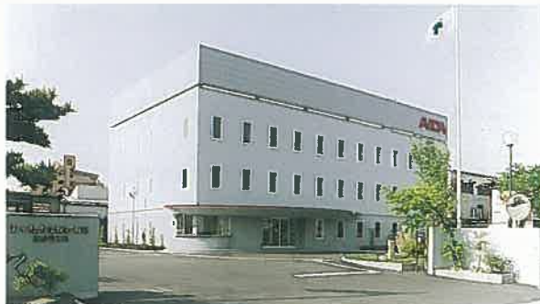
甚目寺工場全景
