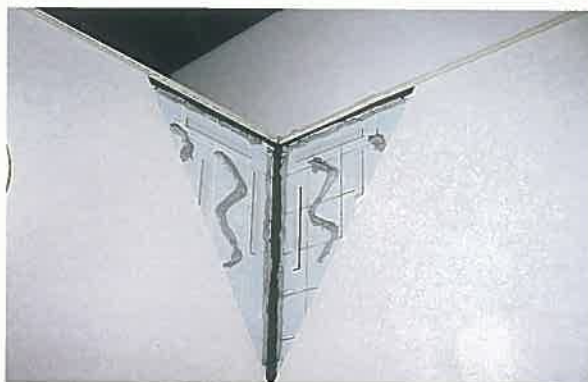
セラールonタイル施工状況
