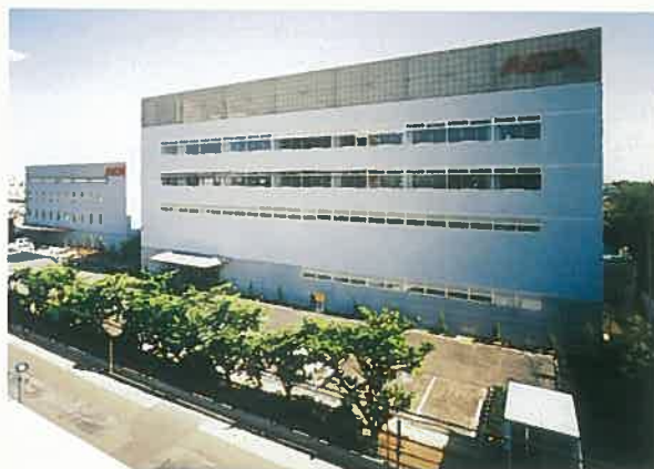
2002年6月竣工したR&Dセンター(研究開発棟)全景
