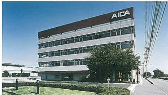
本社・新川工場全景
