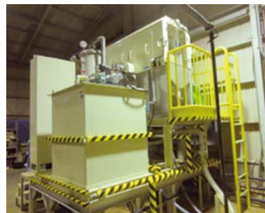
広島工場 廃水処理場
