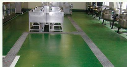
コンクリート下地をコーティングすることで床を保護するとともに、用途に応じて、耐熱・耐薬品・帯電防止などの機能を付与します。工場、物流施設、厨房などで広く採用されています。
