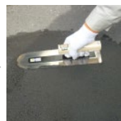
打設・鏝均し
