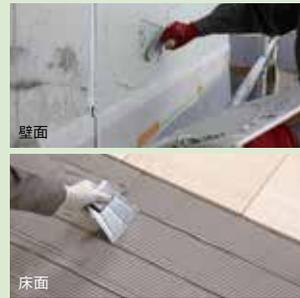
※床施工の場合は盛板をセットせず床に接着剤を直接落とし、そのまま施工できます。
