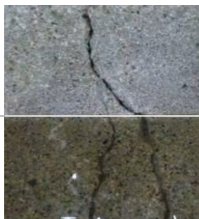
施工後の下地視認性
