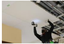
カビテクト施工風景
