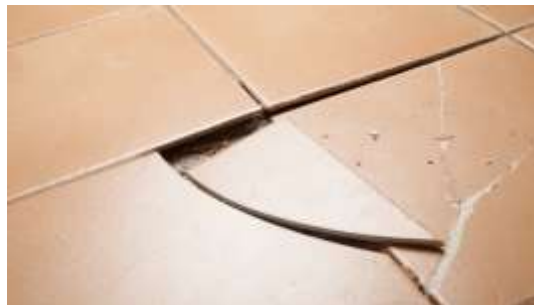
セラミックタイルの欠点
