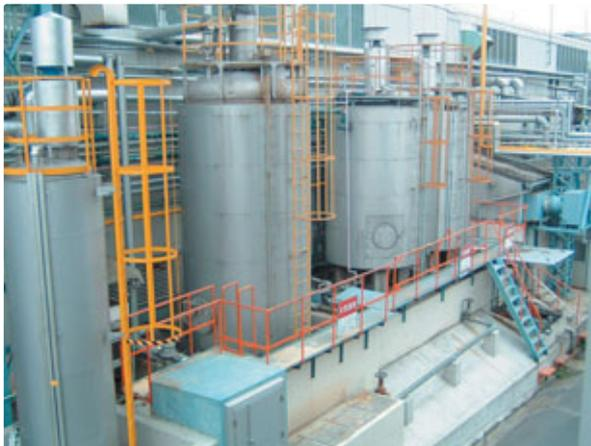
● 本工場樹脂タンク基礎部分のコンクリートによる耐震補強
